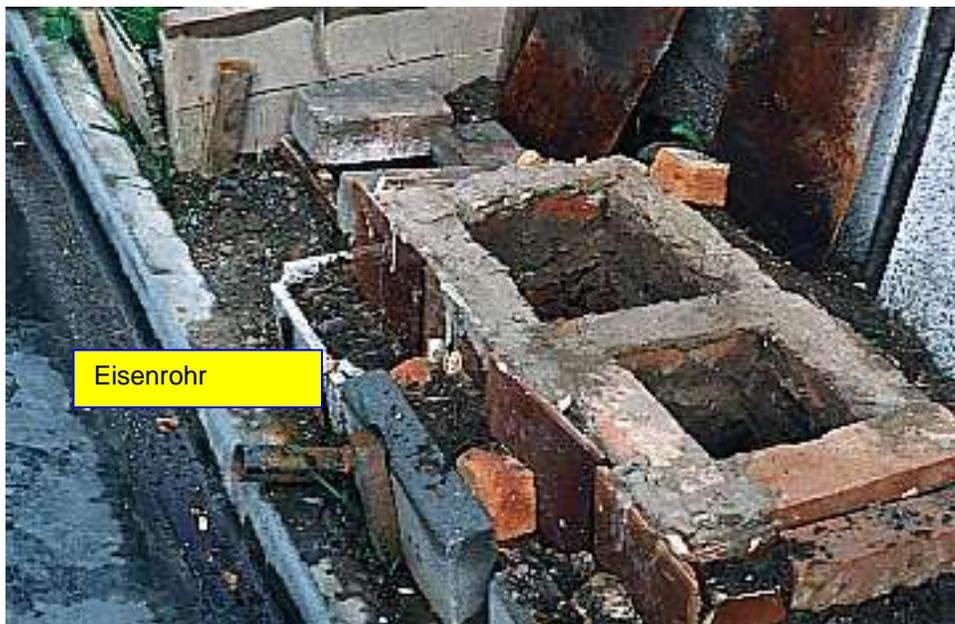
5. An die beiden Rohrenden, die ca. 10 cm an der Oberfläche herausragen, werden die Gebläse angeschlossen. Als Gebläse eignen sich z.B. alte Haarföhne/Staubsauger (umgekehrt verwenden) oder Industriegebläse. Man
